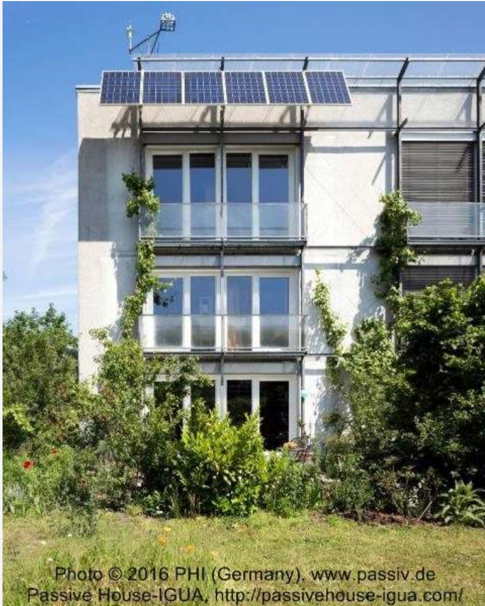
Пілотний проект Пасивного Будинку, побудованого в 1991 році, який пізніше був оснащений фотоелектричними системами.
